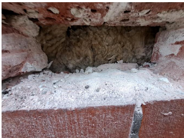
Kuva 35. Etupihan puolella ulkoseinän eristeenä kivivillaa.
