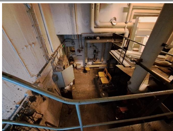
Kuva 15. Maan alla olevissa kellaritiloissa on myös maanvarainen betonilaatta ilman alapuolista lämmöneristettä.
