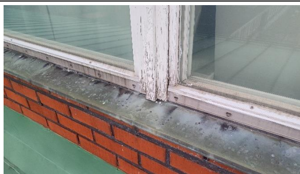
Kuva 38. Liikuntasalin ruokalan puoleiset ikkunat teknisen käyttöön ohittaneita.
