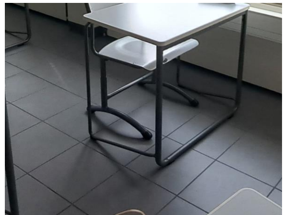
Kuva 22. Luokkiin on vaihdettu muovimattojen tilalle laatat vuonna 2017.
