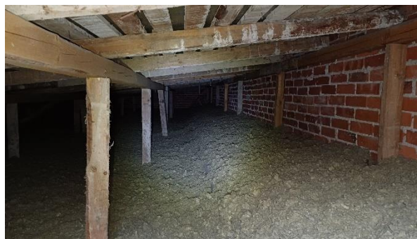
Kuva 54. Ruokalan yläpuolisen yläpohjatilat yleiskuva, ei erillistä aluskatetta vesikatteen alla
