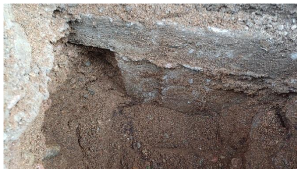
Kuva 10. Matalan osan sokkelin vieren kaivaus: pilari.
