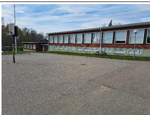
Kuva 1. Piha-alueella asfalttia ja nurmikkoa.
