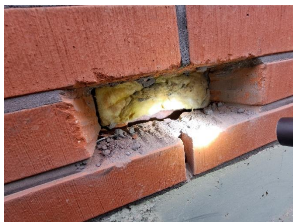
Kuva 34. Ulkoseinissä on eristeenä, sekä lasi- että kivivillaa (mineraalivillaa).
