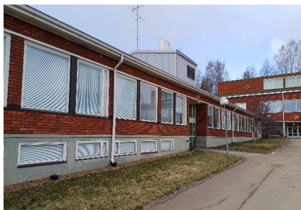
Kuva 4. Etupihan puolella maanpaineiseinällisellä osuudella salaojan tarkastuskaivot.
