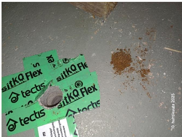
Kuva 23. Alapohjan rakennetarkistusporaus maanvarainen betonilaatta. Alla hienoa hiekkaa.
